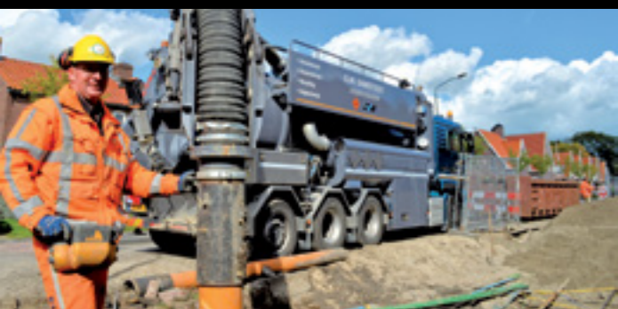
EXCAVATION PAR ASPIRATION
