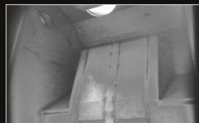
Behälter mit zusätzlichem 240L Wassertank
